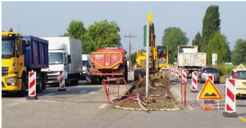
Chantier entrée nord
