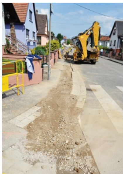
Chantier gaz quartier des Fleurs
