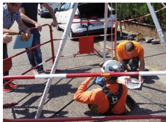
Chantier avenue d'Alsace, exploration du sous-sol
