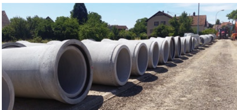
Chantier rue du Nordfeld pour la ZAC
