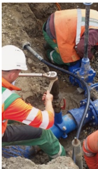
Chantier eau rue du Général de Gaulle
