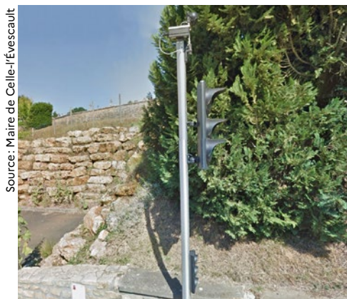
Détecteur hyperfréquence et détecteur vidéo implantés sur le mât du feu
